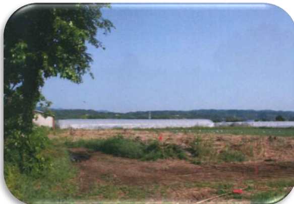
障害物（樹木等）を撤去
